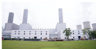
北京热电厂燃机烟气余热利用项目
