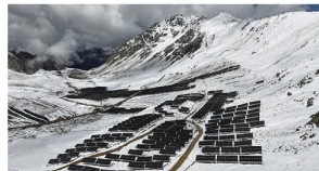
纳古光伏电站一期项目
