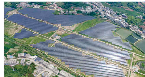
通山南林柔性支架光伏项目
