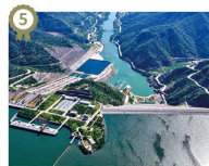
5 华能澜沧江水电股份有限公司 糯扎渡水电站 (蔡山摄)
