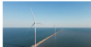
天津港防波堤风电项目
