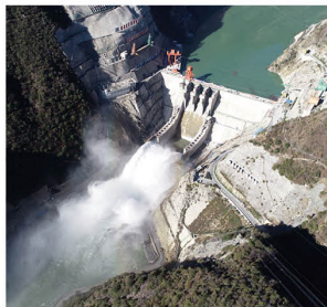
乌弄龙水电站
