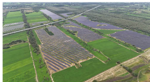
彰武光伏复合治沙示范项目
