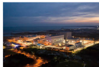
石岛湾高温气冷堆示范工程
